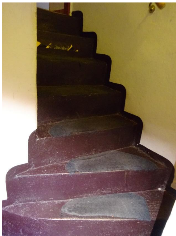
Obrázek 5 – Schody pohled zespodu
