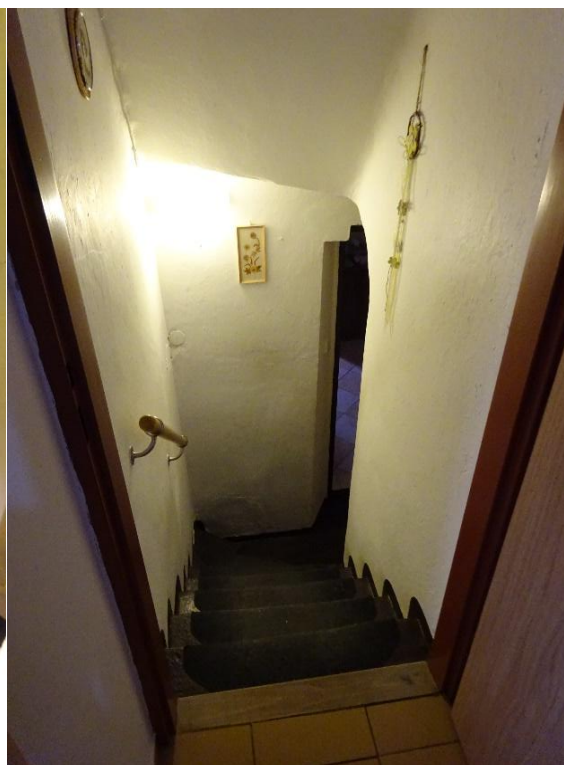
Obrázek 6 – Schody pohled shora
