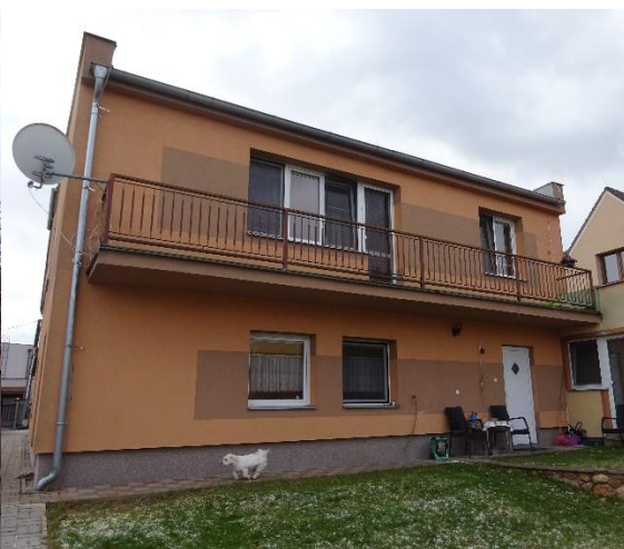
Obrázek 2 – Budova zařízení pohled ze zahrady
